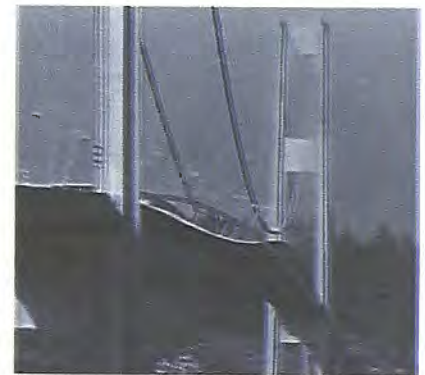
FIGURA 21.6 A intensidade de uma onda estacionária é máxima nos antinodos e nula nos nodos.
