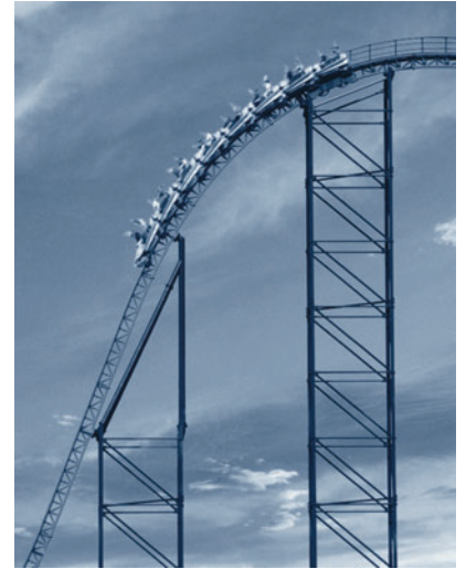
A energia potencial da montanha-russa é convertida em energia cinética enquanto ela acelera em direção à base da descida.
